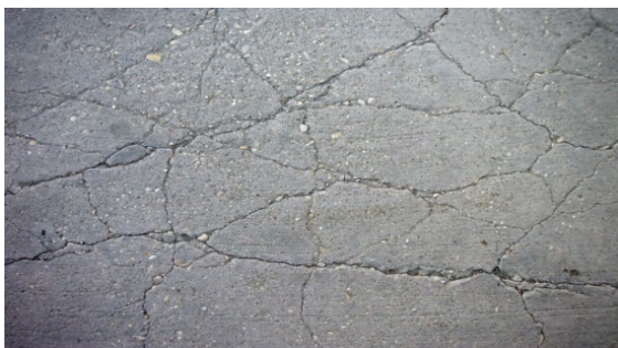
ნახ. 1. ბზარები და დეფექტები პორიზონტალური ბეტონის ზედაპირზე
