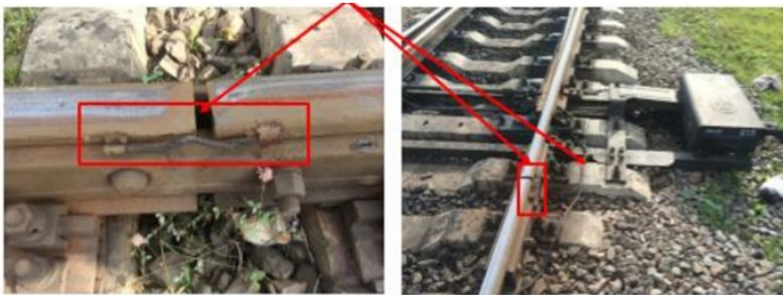
ნახ. 4. შედუღებული (დუბლირებული) შემაერთებლების კონტროლი
