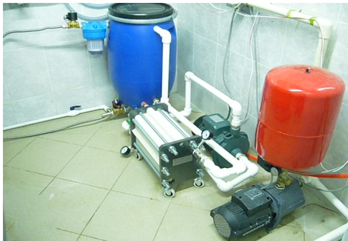
ნახ. 5. შპს “ოქროს კათხაში” დამონტაჟებული წყლის ნანოფილტრაციული მემბრანული დანადგარი
