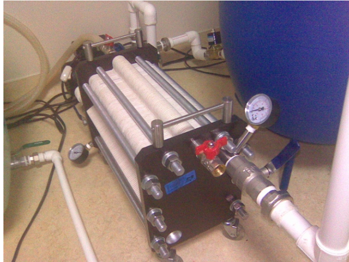
ნახ. 4. შპს „ავერსის კლინიკის“ მიკრობიოლოგიურ ლაბორატორიაში დამონტაჟებული 400 ლ/სთ მწარმოებლურობის საწარმოო ულტრაფილტრაციული მემბრანული დანადგარი
