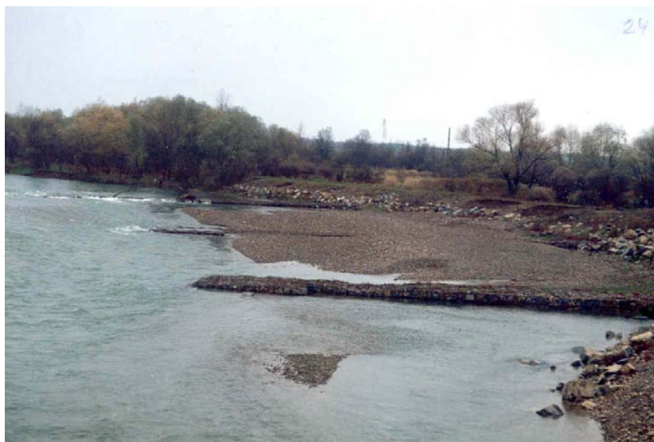
Рис. 1. Защита берега низкими затапливаемыми полузапрудами у с. Добровляны на р. Ломница. Видно занесение межполузапрудных пространств наносами
