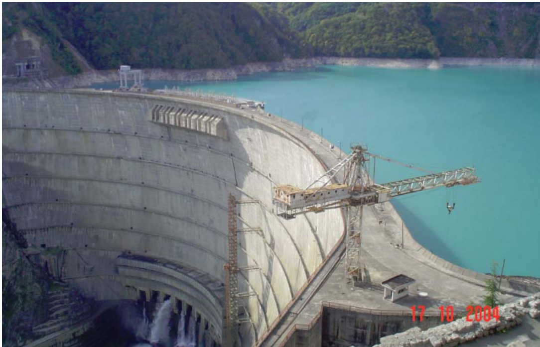
ნახ. 1. ენგურჰესის რკინაბეტონის თაღოვანი კაშხლის საერთო ხედი
